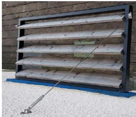
Vue de détail fixation tirant inox sur façade.
